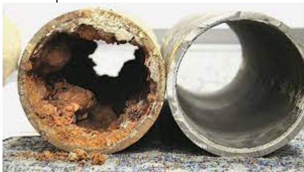
Рис. 4. Загальний вигляд корозії труб НКТ
